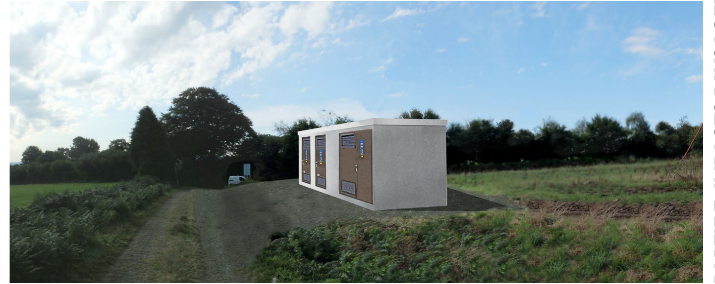
Photo 82 : Exemple de PDL finition béton peint
