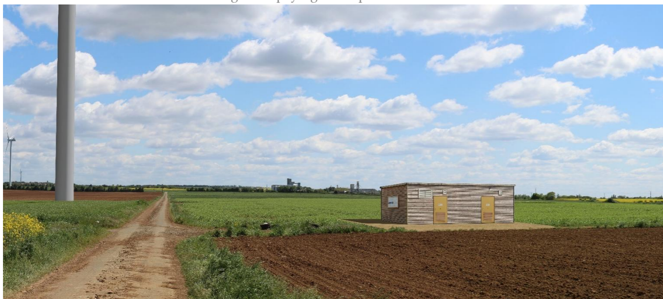
Intégration paysagère du poste de livraison
