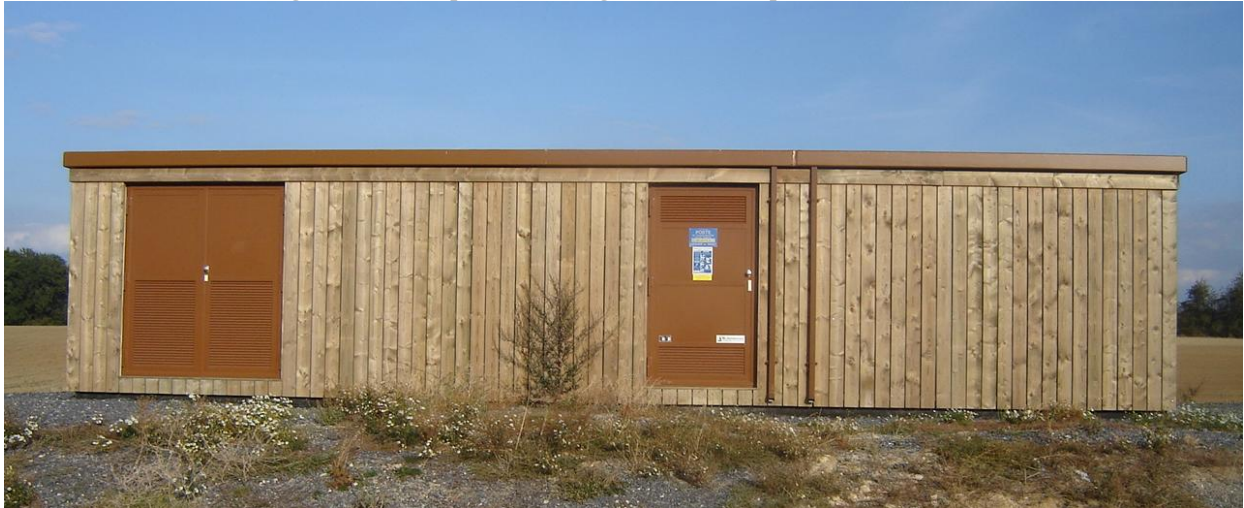
Figure 6 : Exemple de bardage bois sur un poste de livraison
